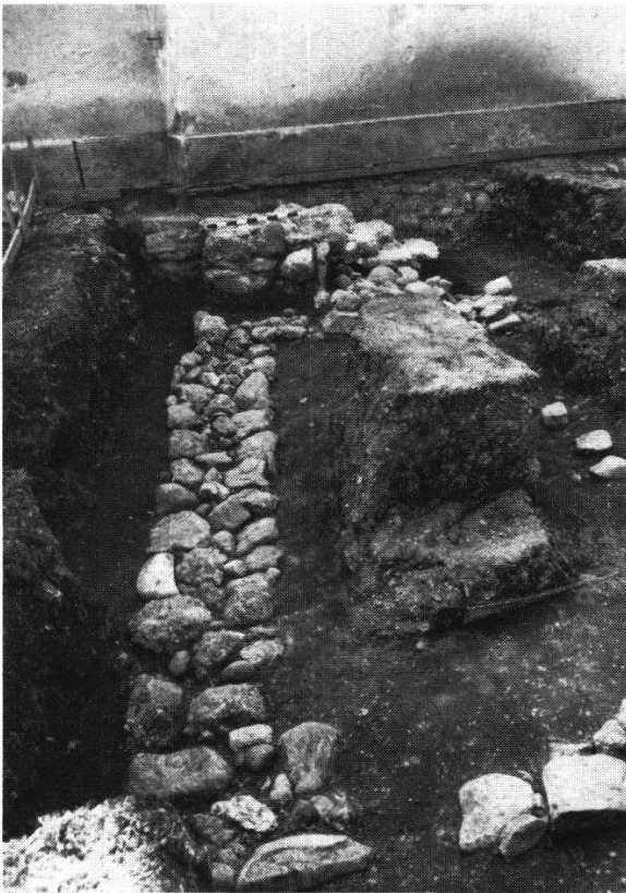
Abb. 35 Chorerweiterung II, Südostecke nach Westen.
