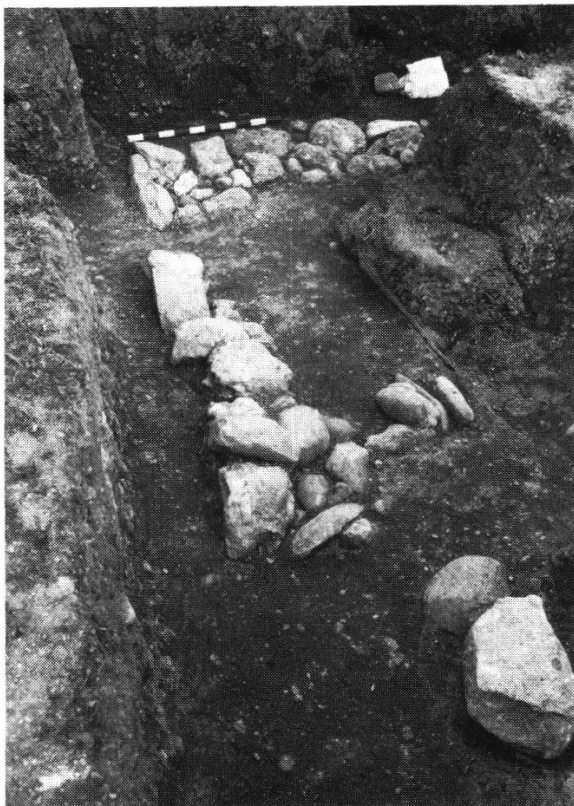
Abb. 37 Chor II, Ostmauer. Im Hintergrund Südostecke der Erweiterung III.
