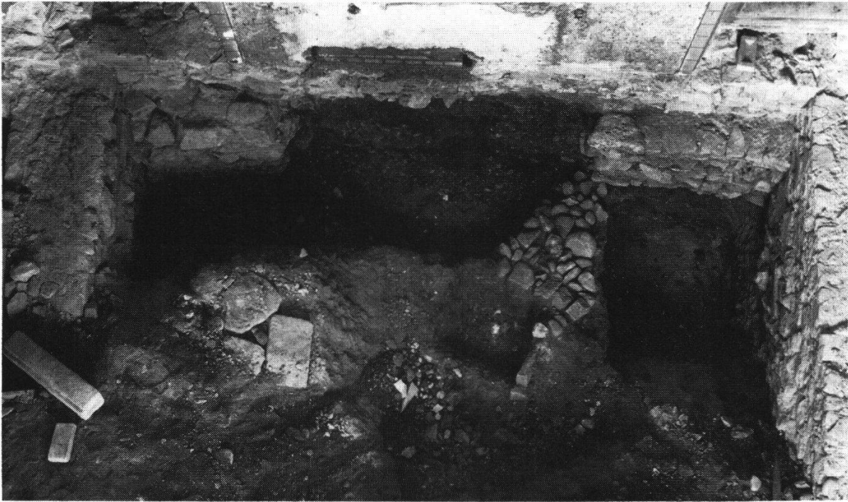
Abb. 55 Inneres Chor gegen Trennmauer zum Altarhaus. Am Bildrand die parallelen Seitenmauern des Chörleins von 1616. Unter der Trennmauer Triumphbogen-Fundamente (1616). Davor das kleinsteinige Fundament zum ältesten Bau.
