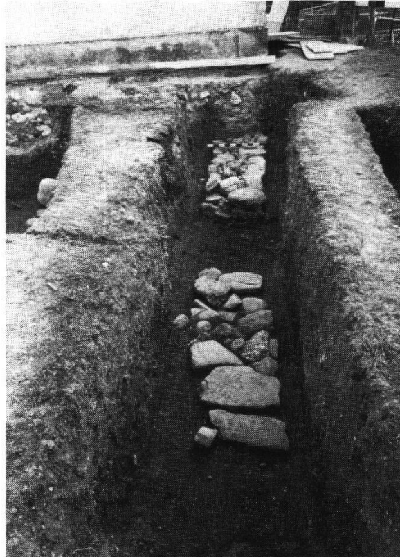
Abb. 38 Chorerweiterung III Nordseite, Blick nach Westen. Im Hintergrund Nordmauer Schiff II, unterbrochen durch (beseitigte) Turmfundamente.
