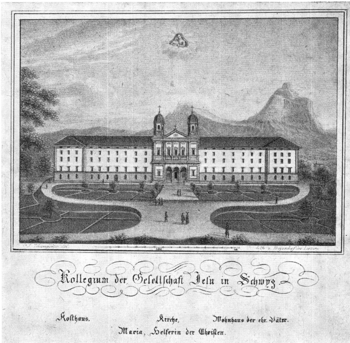
Gesamtansicht des Jesuitenkollegiums
