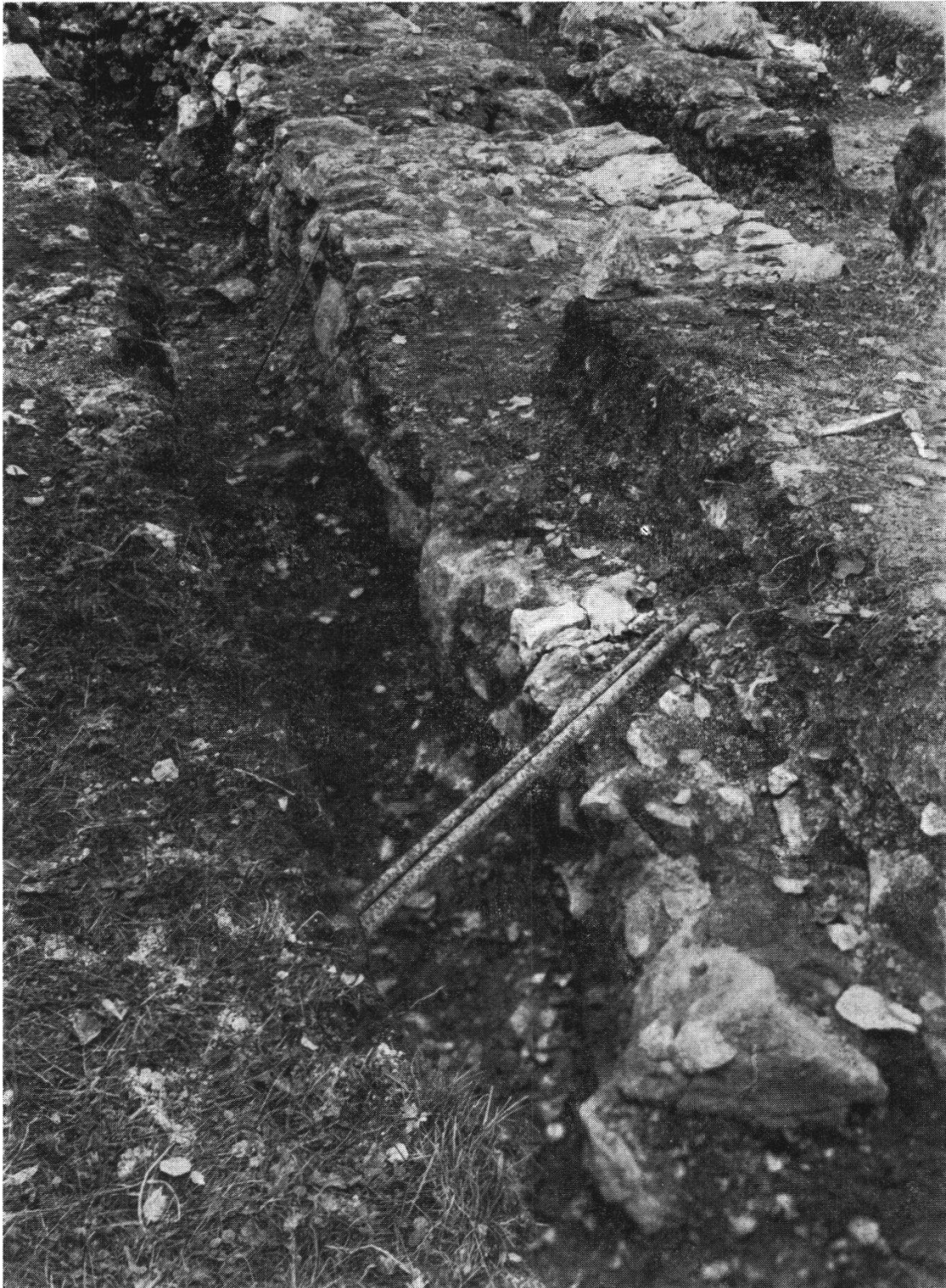
Aufnahme der Innenseite der talseitigen Fundamentmauer, aufgenommen von der SW-Ecke her. Man beachte hier unmittelbar unter den Wasserleitungen den durch die Mauerabwinkelung bedingten teilweisen Unterbruch der Mauermantelkonstruktion (Westmauer ist ganz ausgehoben).
