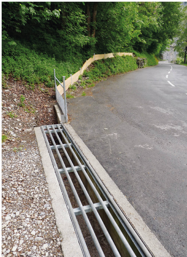
Abb. 138. Amphibienzaun mit Unterführung an der Strasse entlang des Klöntalersees. Solche Leitwerke sollen die Amphibien unter der Strasse durchführen, um den Strassentod zu verringern.
