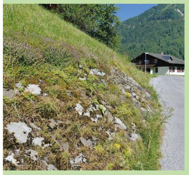
Abb. 141a. Trockenmauer zur Hangstabilisierung, Badegg, Luchsingen.
