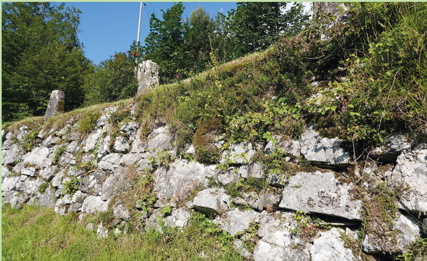
Abb. 141d. Stützmauer der alten Strasse von Riedern ins Klöntal.
