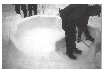
5. Posare i primi blocchi nel senso dell'altezza, seguendo una forma a «spirale».
