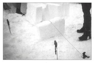
2. Determinare il centro con un bastoncino da sci e assicurarvi una cordicella per il perimetro, che servirà anche a controllare costantemente il raggio e l'inclinazione.
