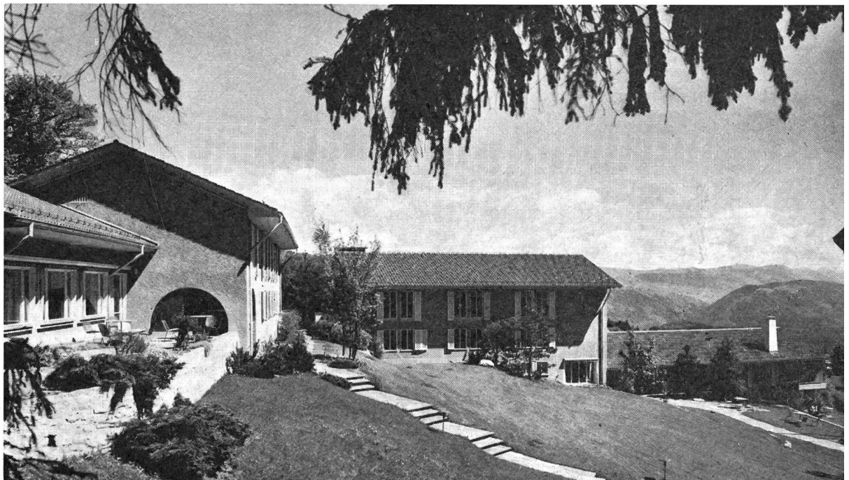
SLL-Gebäude Pavillon de l'ANEP Padiglioni dell'ANEF
