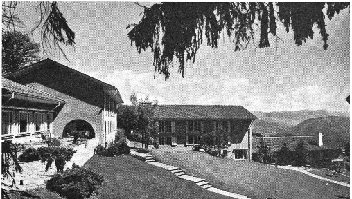
SLL-Gebäude Pavillon de l'ANEP Padiglioni dell'ANEF
