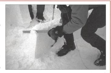
Longueur totale de la scie (60 cm) = longueur du bloc Longueur de la lame (45 cm) = hauteur du bloc Longueur de la poignée (15 cm) = épaisseur du bloc
