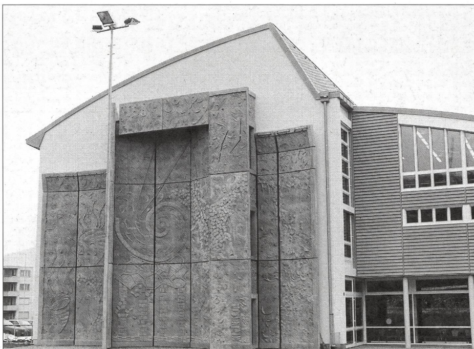
Mur d'escalade à Liestal.
