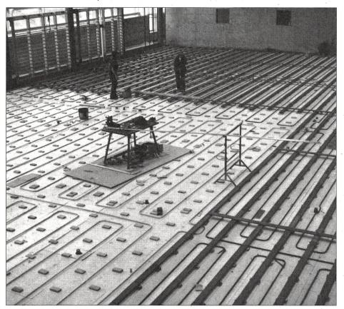
Plancher flottant avec chauffage par le sol.
