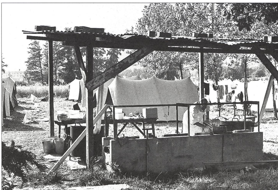
Infrastructure simple et pratique.
