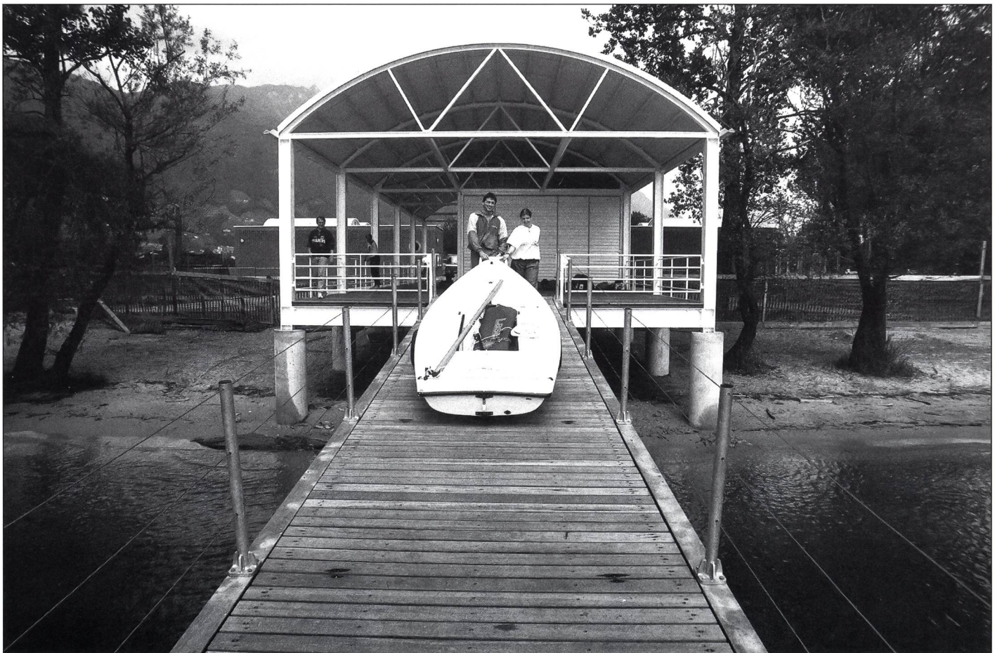
Nouveaux hangars pour bateaux à Tenero: conçus par Mario Botta, architecte de réputation mondiale, ils vont abriter planches à voile, canots et autres petites embarcations. C'est un premier pas vers l'agrandissement attendu du CST.
