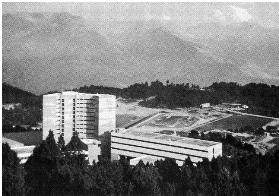
La construction du Centre d'entraînement en altitude de Font-Romeu en voie d'achèvement: Français et étrangers allaient s'y préparer ferme avant les JO de Mexico.
