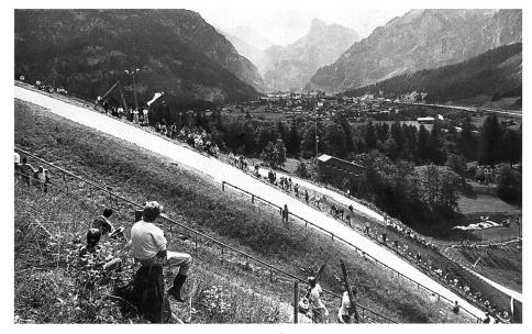
(plus de 41000 lamelles en tout). Un système d'arrosage actionné à distance permet à l'eau nécessaire à la «glisse» de se répartir judicieusement.
