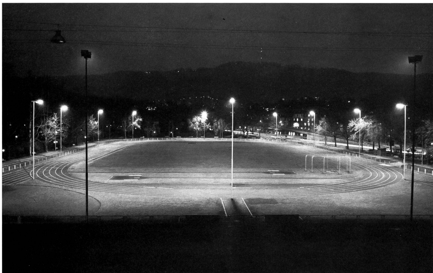
Installations d'athlétisme du Sihlhölzli, Zurich.
