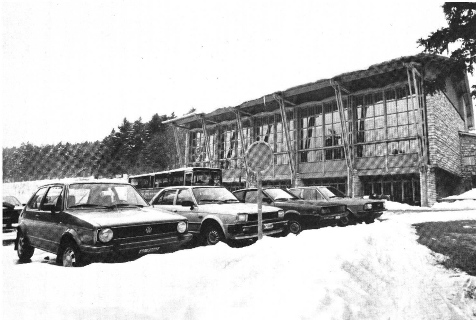
Quand on vient de loin, l'emploi d'un véhicule motorisé peut se justifier pour accéder à la salle de sport.
