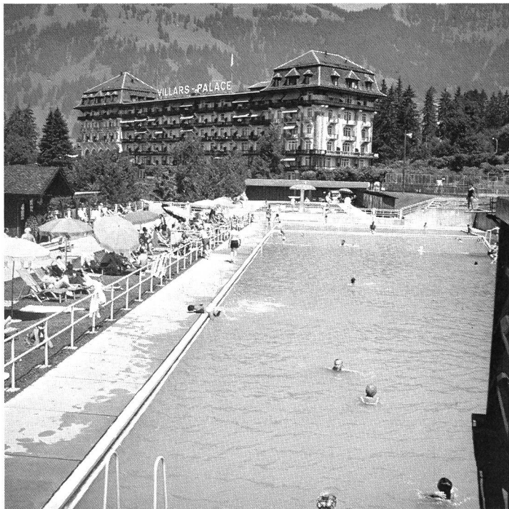
Piscine en plein air: natation limitée à la belle saison.
