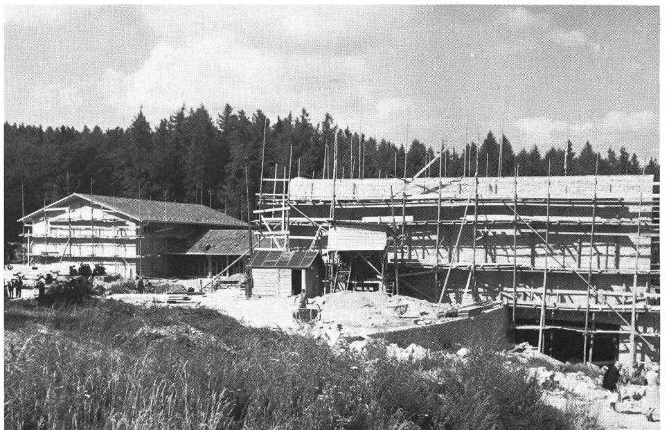
Construction de la «grande salle de sport», en 1947.
