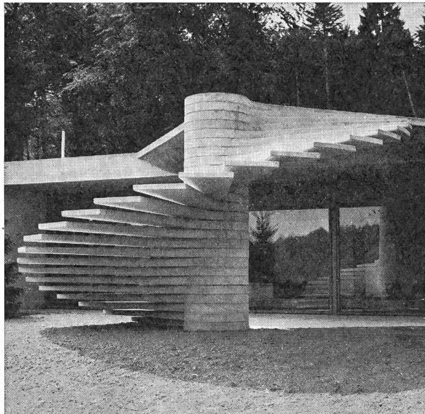
Gros plan de l'escalier en colimaçon, composé d'éléments préfabriqués, qui relie la plate-forme située à la hauteur de la galerie avec le hall d'entrée.
