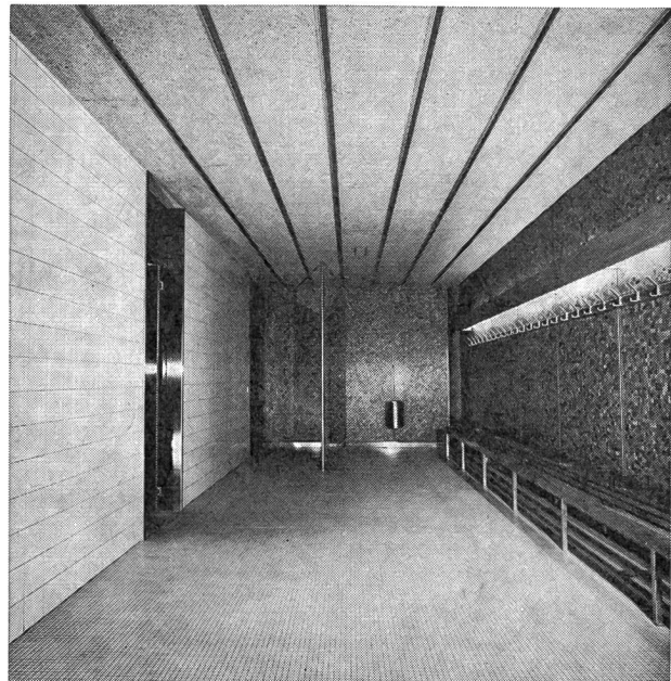
Vestiaires avec, à gauche, l'entrée aux douches équipées de sècheurs et d'installations de désinfection des pieds.
