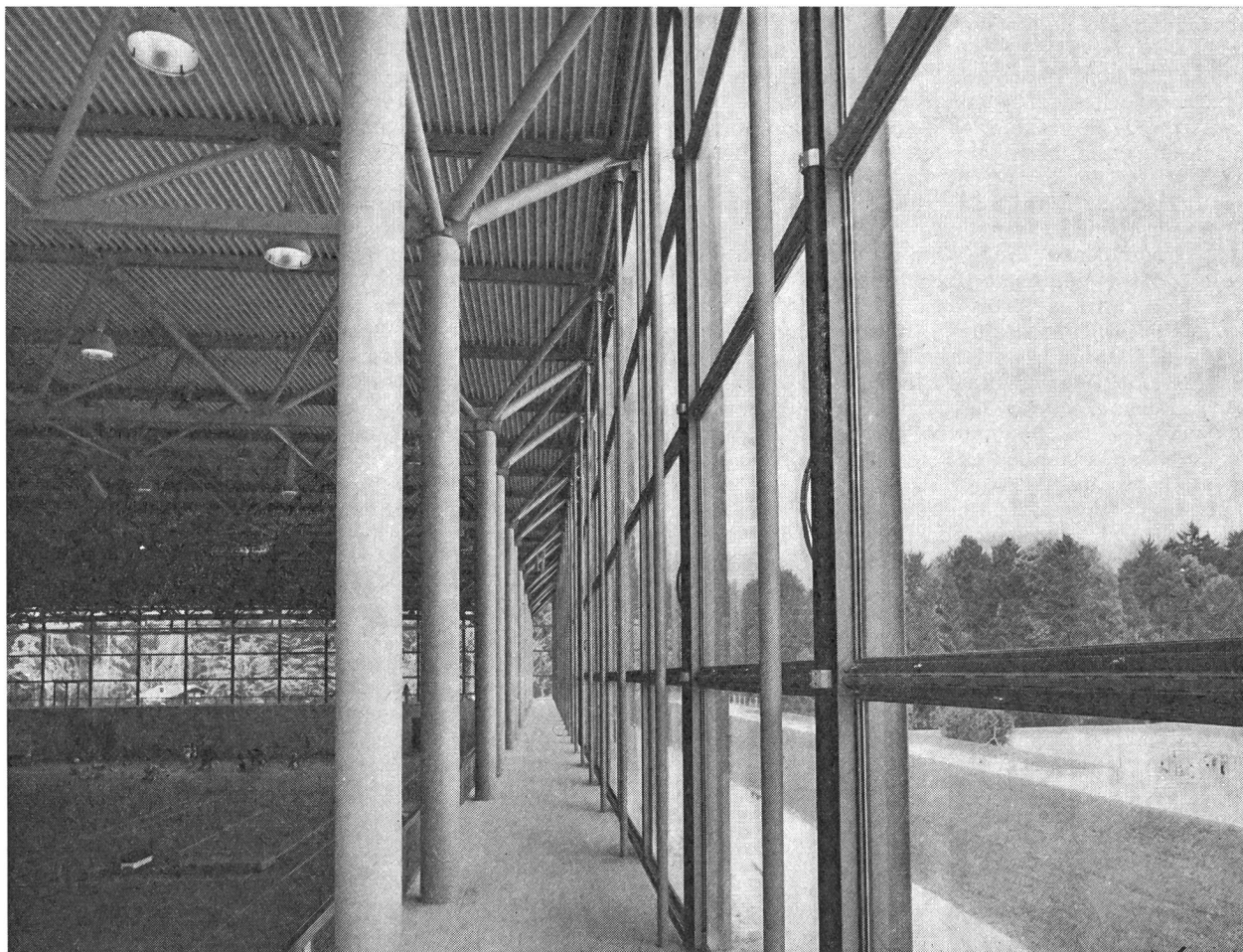
Galerie avec les piliers en acier, câbles de précontrainte enveloppés à l'intérieur des façades. Cette photo montre la liaison entre l'intérieur et l'extérieur.
