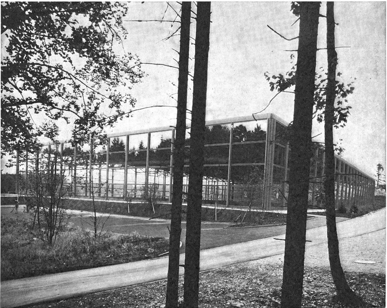
Structure métallique de la salle vue de l'ouest, à gauche le parc de stationnement.
