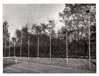
Aspect des 4 projecteurs de iode montés latéralement, adaptés à la hauteur normale des grilles, pour l'éclairage d'une place à deux terrains.
