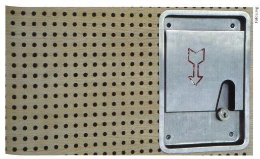
Richtig ist es, wenn das Prinzip der glatten Wände realisiert wird: Die Türgriffe sind flächenbündig eingelassen.
