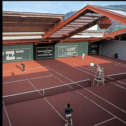
AGOB-Schiebedachhallen Tenniscenter Grütze Winterthur
