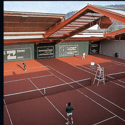
AGOB-Schiebedachhallen Tenniscenter Grütze Winterthur
