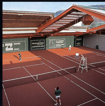
AGOB-Schiebedachhallen Tenniscenter Grüze Winterthur
