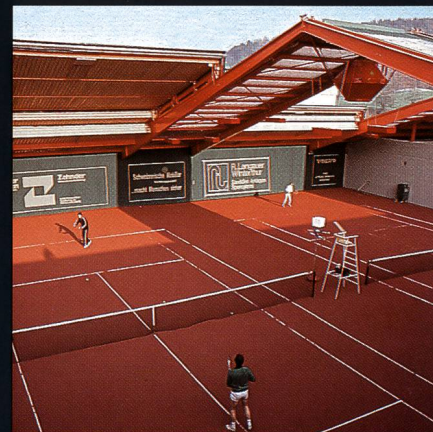
AGOB-Schiebedachhallen Tenniscenter Grütze Winterthur
