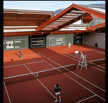
AGOB-Schiebedachhallen Tenniscenter Grütze Winterthur
