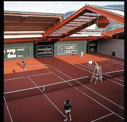
AGOB-Schiebedachhallen Tenniscenter Grütze Winterthur
