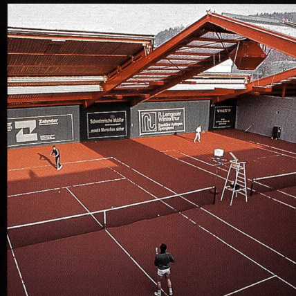
AGOB-Schiebedachhallen Tenniscenter Grütze Winterthur
