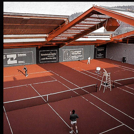
AGOB-Schiebedachhallen Tenniscenter Grütze Winterthur
