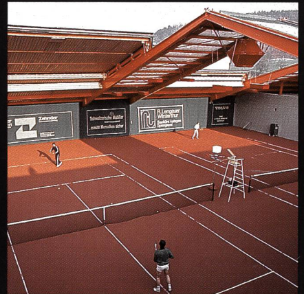
AGOB-Schiebedachhallen Tenniscenter Grütze Winterthur
