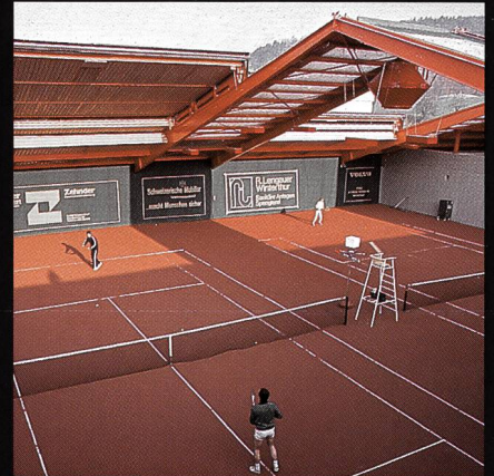
AGOB-Schiebedachhallen Tenniscenter Grüze Winterthur
