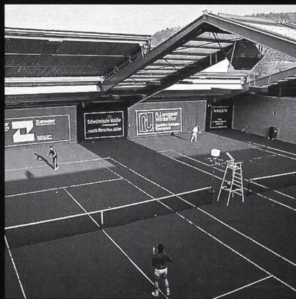
AGOB-Schiebedachhallen Tenniscenter Grütze Winterthur
