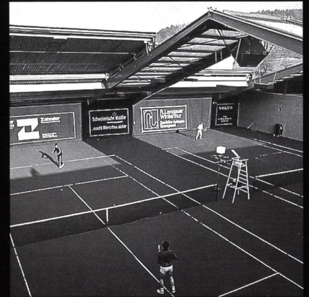
AGOB-Schiebedachhallen Tenniscenter Grütze Winterthur
