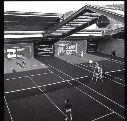
AGOB-Schiebedachhallen Tenniscenter Grütze Winterthur
