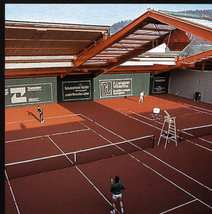
AGOB-Schiebedachhallen Tenniscenter Grütze Winterthur
