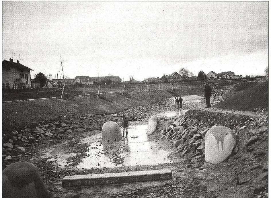
Der «Parc d'eaux vives» in Hünigen (F) kurz vor der Fertigstellung.
