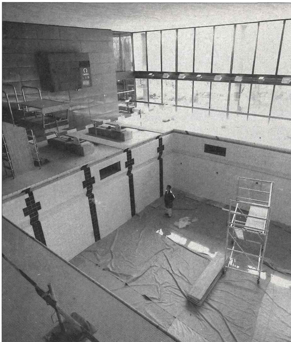
Revision: Das Hallenbad im Schulgebäude muss umfassend saniert werden. Vom Mai bis September dauern die Renovationsarbeiten, die vor allem eine Erneuerung der technischen Einrichtungen, den Einbau von Unterwasserlicht und einen neuen Hubboden umfassen.
