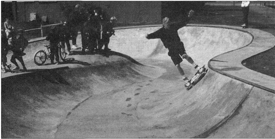
Ein «Snake-Run» (Schlangenbahn) aus Ortbeton.
