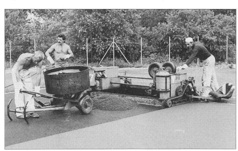
Einbau des Kunststoffbelages für die 100-m-Bahn in Tenero.
