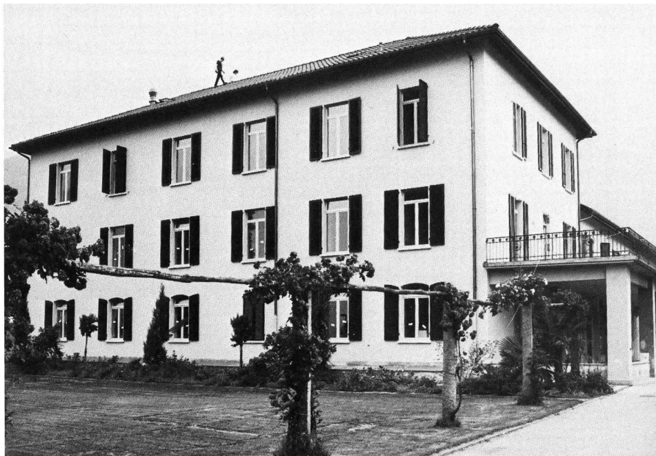
Das alte Unterkunftsgebäude: Erhaltung der Bausubstanz bei der Sanierung.
