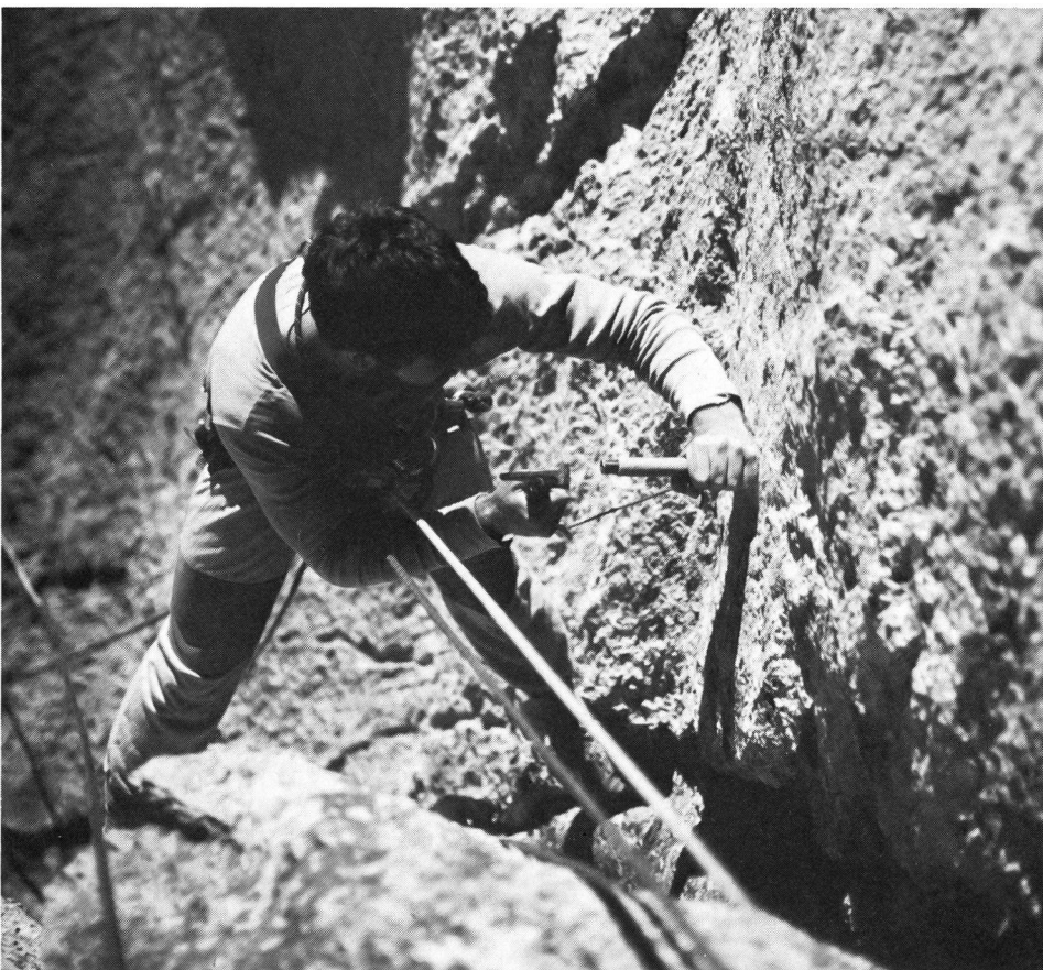
Absichern «von oben»: Aus dem hängenden Seil kann der Bohrhaken an jeder beliebigen Stelle gesetzt werden.
