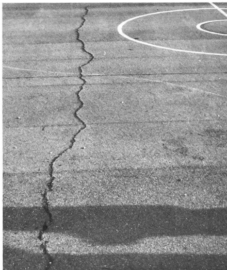
Risse im Belag eines Trockenplatzes.
