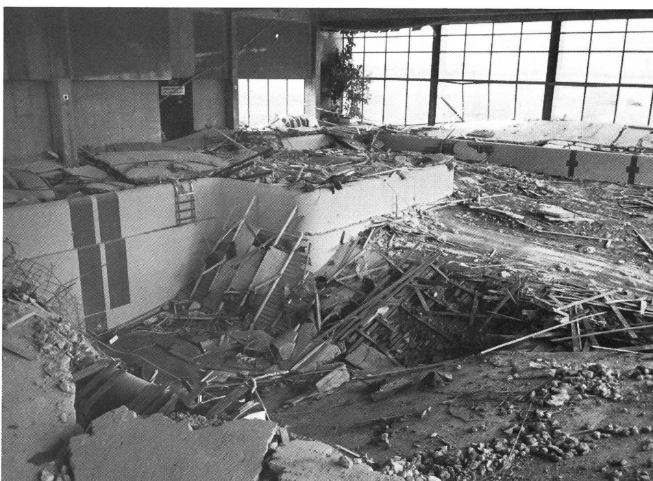
Bauschäden, die zur Katastrophe führten: Einsturz der Decke des Hallenbades von Uster am 9. Mai 1985, wobei zwölf Menschen ums Leben kamen.
