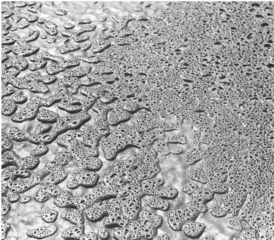
Witterungsschäden nach dem Belagsauftrag. Wer bezahlt?
