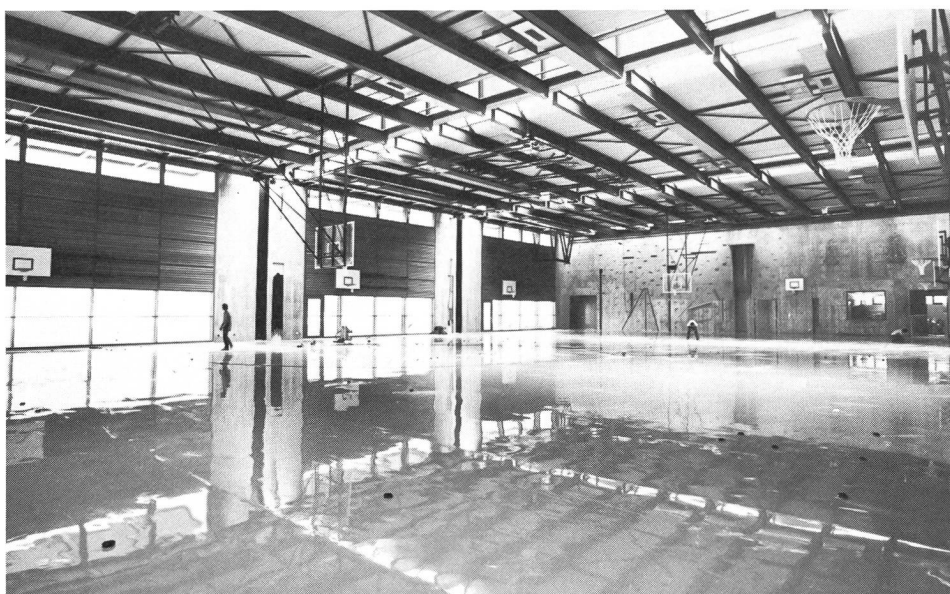
Die Dreifach-Sporthalle von 27 × 45 × 8 m während des Auftragens der verschiedenen Belagschichten.
