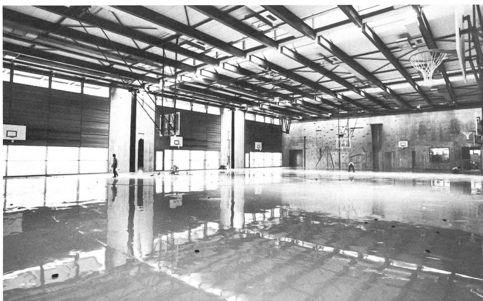
Die Dreifach-Sporthalle von 27 \times 45 \times 8 m während des Auftragens der verschiedenen Belagschichten.
