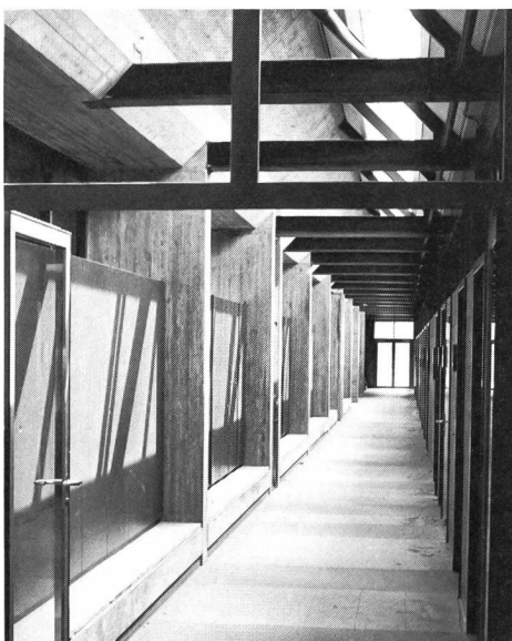
Auf eine Trennung von Schmutz- und Saubergang parallel zur Sporthalle wurde verzichtet. Als Ersatz wurden Schmutzschleusen und eine Hochdruck-Reinigungsanlage installiert. Auf der rechten Seite des Durchgangs befinden sich die Garderoben, Toiletten und Duschenanlagen.
