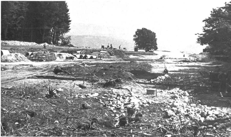
Bau der ersten Aussenanlagen 1947: Der Lärchenplatz, noch heute Schmuckstück der ETS.
