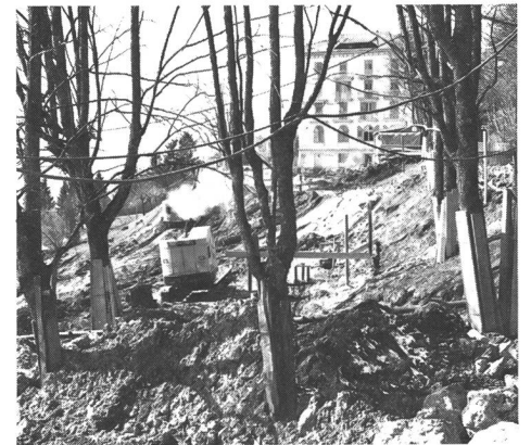
Magglingen 1968: Das grosse Loch. Bau des neuen Schulgebäudes und damit Abschied von einer «alten» und Einläuten einer neuen Zeit.
