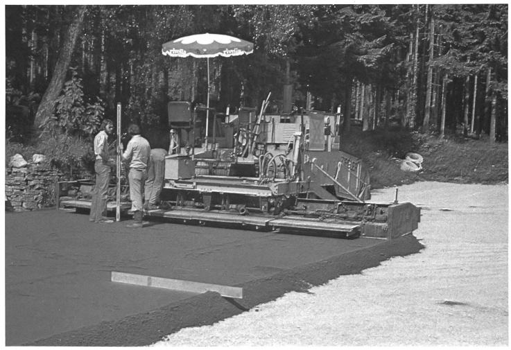
Hochmechanisierter Sportrasenbau – Mit einem Strasseneinbaufertiger wird das, ausserhalb des Spielfeldes mit Spezialmaschinen aufbereitete Rasentragschichtgemisch über dem wasserdurch-
