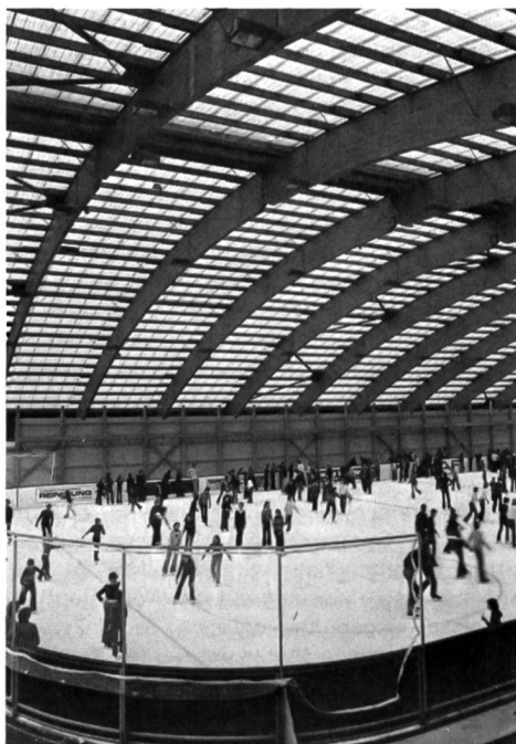
Für die Mehrzahl der gedeckten Eisbahnen und -hallen in unserem Land ist eine moderne Holztragwerkkonstruktion gewählt worden. Für die Wahl der Bauweise in Holz sprechen sowohl deren Zweckmässigkeit, Ästhetik und Wirtschaftlichkeit wie auch der materialtechnische Vorzug, dass bei Holz keine Probleme mit Kondenswasser und Tropfenbildung auftreten.
