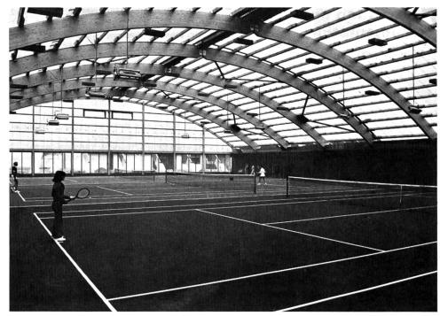
Die zunehmende Anwendung des Holzes für den Bau von Tennishallen beweist, dass mit diesem Werkstoff grosse Raumdimensionen in eindrücklicher Weise überbrückt und in kostengünstiger Ausführung verwirklicht werden können.
