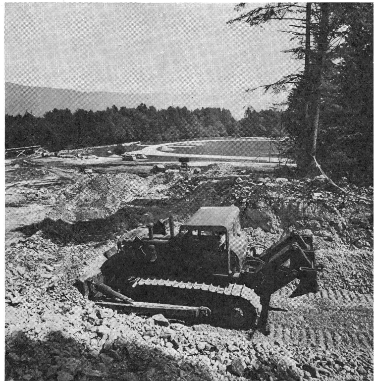
Aushub Mai 1974. Noch war der Bauplatz ein wüster Schutthaufen
