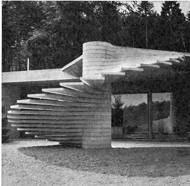
Nahaufnahme der Wendeltreppe in vorfabrizierten Elementen, als Hauptverbindung der auf Galeriehöhe gelegenen Plattform mit der zentralen Eingangshalle.
