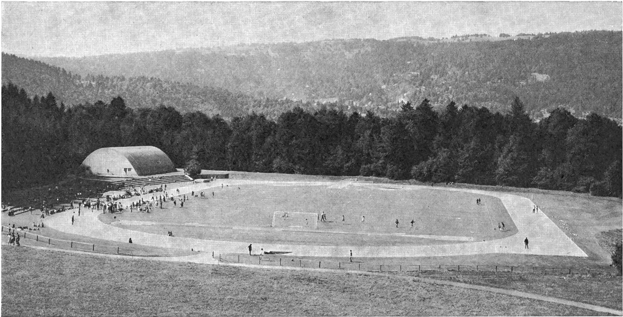
«End der Welt» vor Inangriffnahme der Bauarbeiten Gross-Sporthalle.
