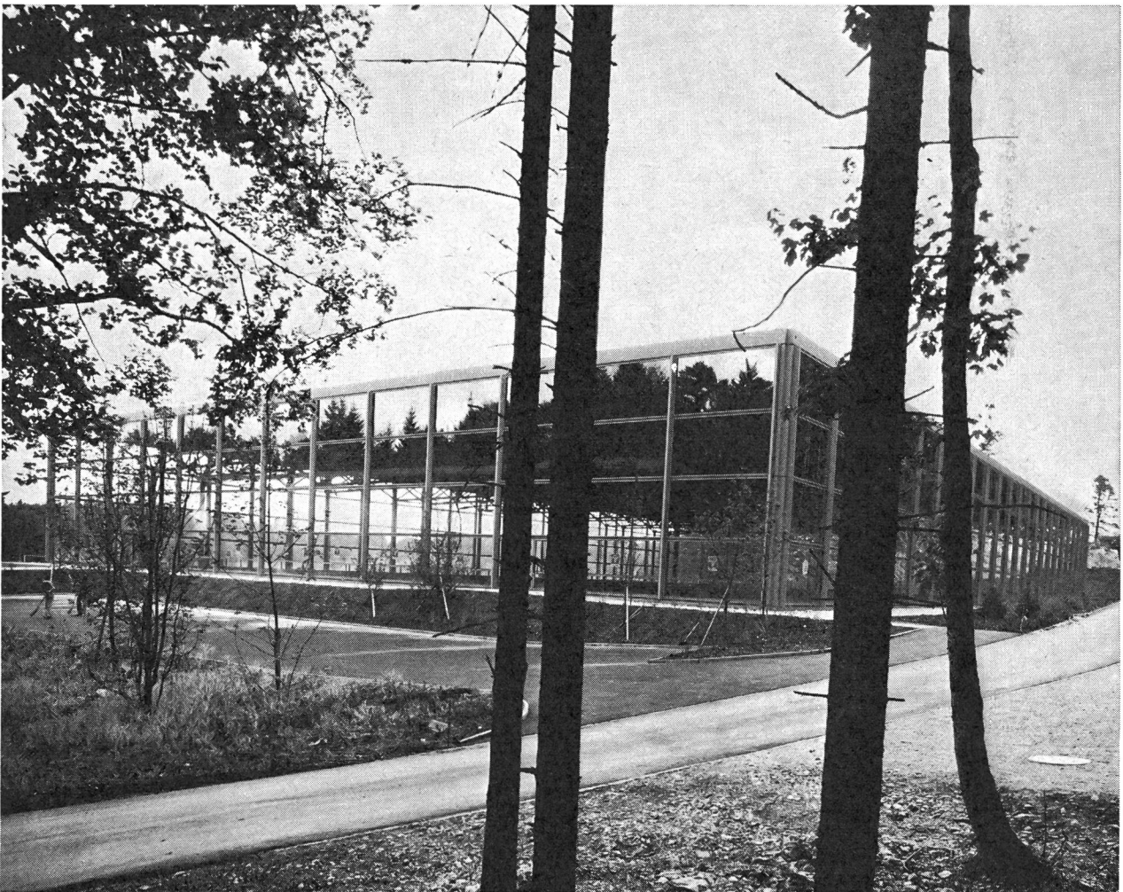
Stahlaufbau Halle, aufgenommen von Westen, links Parkplatz.
