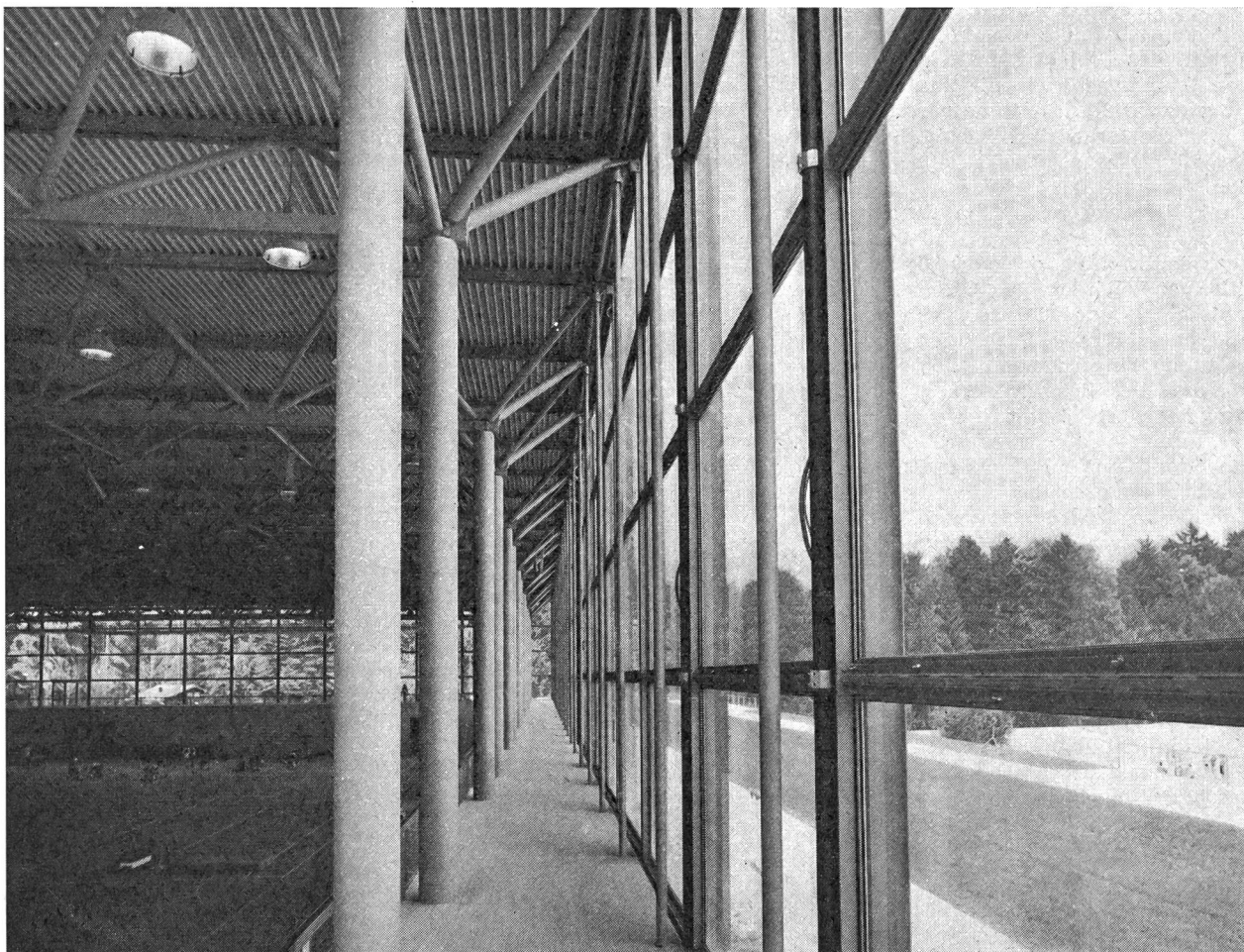
Galerie mit Stahlstützen, ummantelten Spannkabeln innerhalb der Fassaden. Die Aufnahme zeigt die Verbindung von Innen- und Aussenräumen.
