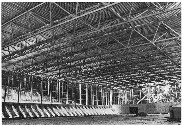
Innenansicht Halle im Rohbau mit Stahlstruktur und vorfabrizierten Trägern der Tribüne.
