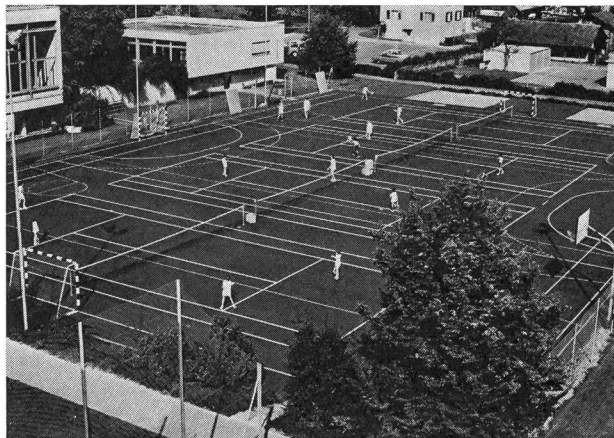
Turn- und Spielplatz in Meggen LU — Belagsmaterial: Dunlop-Varioplast, offenporig polyurethan-versiegelt, rot.
