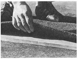
Das Bild zeigt den Unterbau, einen Asphaltstrassenbelag, den Pad, einen etwa 16 mm dicken Schaumgummi und die rasenähnliche Oberfläche aus robusten Nylonfasern (etwa 13 mm).
