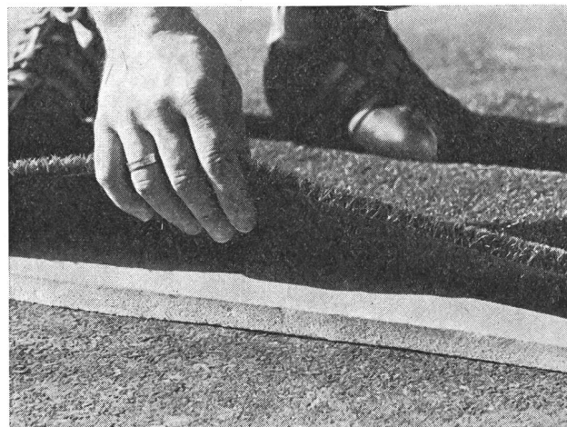
Das Bild zeigt den Unterbau, einen Asphaltstrassenbelag, den Pad, einen etwa 16 mm dicken Schaumgummi und die rasenähnliche Oberfläche aus robusten Nylonfasern (etwa 13 mm).
